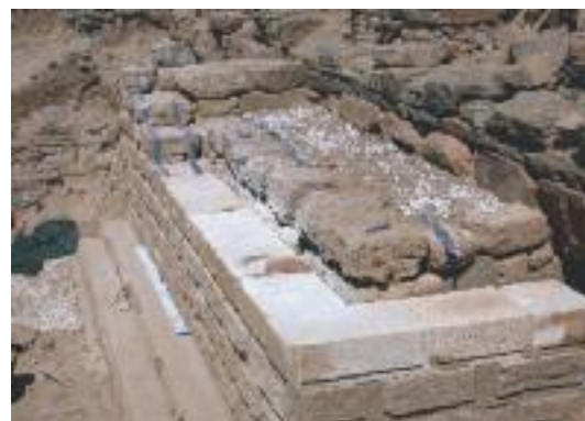
Il restauro in corso d'opera. Particolare
