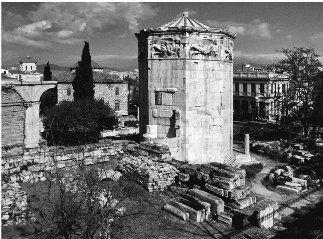
Fig. 1 - La Torre dei Venti, vista da SE
