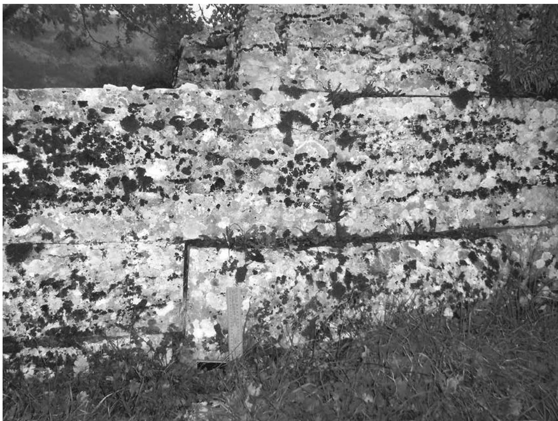
Fig. 6 - Lato E, elevato: il punto in cui si verifica la transizione dall'insieme di *euthynteria* e *toichobates* (a sn.) a un'unica assisa di alt. equivalente (foto Autore)
