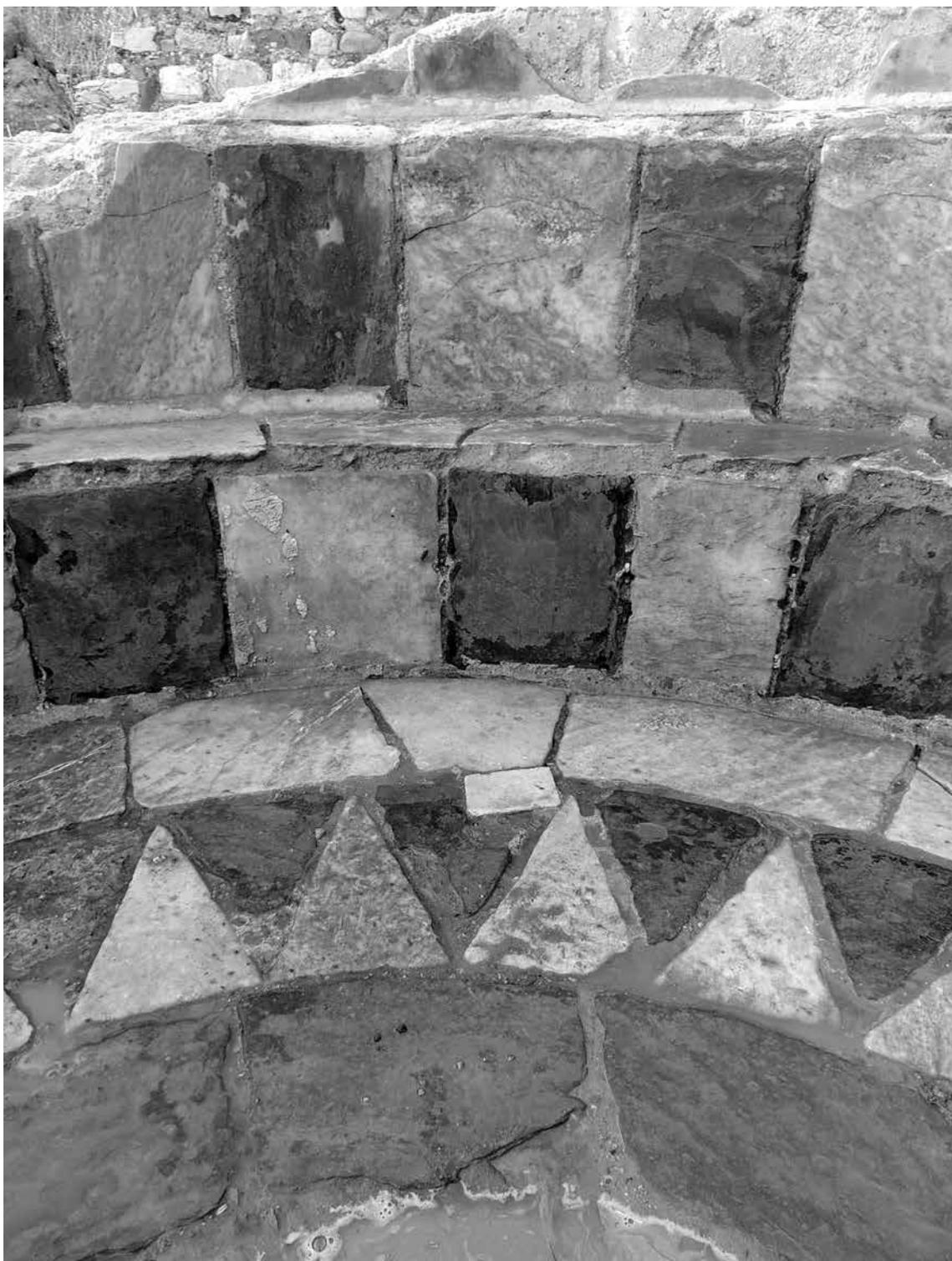
Fig. 14 - Dettaglio del rivestimento in lastre di marmo bianco e ardesia del *loutron*
